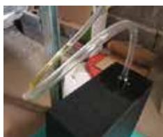
Difuzér je umiestnený pod VZT a hadica je skrúteným tvarom napojená smerom hore. Dochádza k spätnému chodu zatomizovaného oleja, ktorý v hádici po čase kondenzuje späť na olej. Zatomizovaný olej sa tlačí von opačným smerom – vid' mastný flak pri výpustku.
